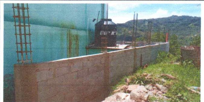
Foto 6: Foto 5: Sustrucción muro perimetral 50 mts.
